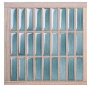
タイルのエッジと 同系色の目地
